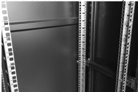
- zamontować koszyki pod śruby M6
